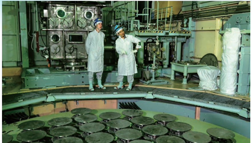
写真1 / 「ふげん」の廃止措置について現場で実習している様子
